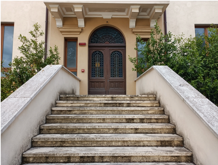
Figura 1: Ingresso COT – Vista frontale
