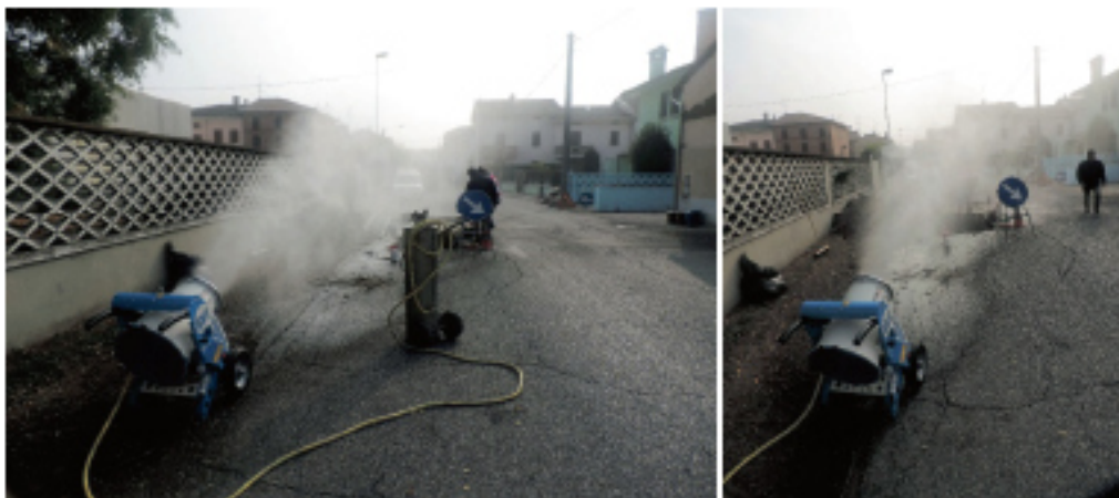
Figura 5 - Cannone nebulizzatore nell'area d'intervento.
